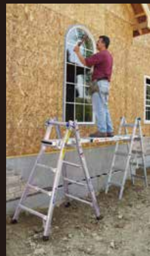
两个自支撑脚手架支架 (配合工作平台及绳索使用)
